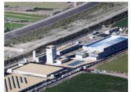
Planta desaladora Bajo Almanzora Emplazamiento: Almería (España) Capacidad: 20 hm 3 /año
