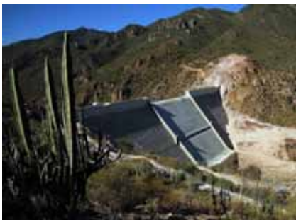
Presa El Realito - Suministro de agua San Luis de Potosí y Guanajuato - CONAGUA Emplazamiento: San Luis de la Paz (México) Capacidad: 86.400 m 3 /día
