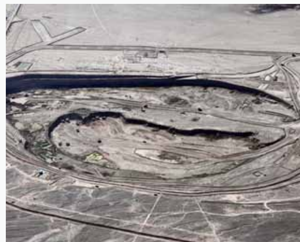
Planta: Ministro Hales Codelco División Norte Localización: Calama, II Región de Antofagasta (Chile) Capacidad: 200 kton de cobre fino
